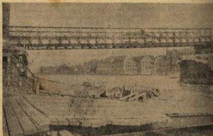
Fig. 2 — A ponte de circunstância construída sob a Bailey, na brecha Noite, em Regensburg
