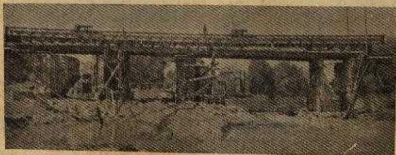
Fig. 1 — Início da construção da ponte de circunstância sob a Bailey
