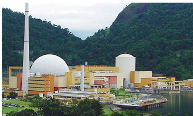
Figura 1 – Central Nuclear Almirante Álvaro Alberto Fonte: Eletronuclear, 2022a
