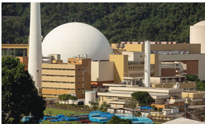
Figura 3 – Angra 2 Fonte: Eletronuclear, 2022c
