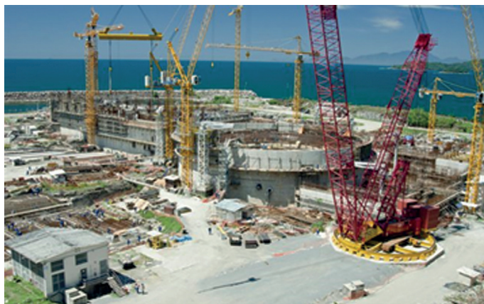
Figura 4 – Angra 3 Fonte: Eletronuclear, 2022d
