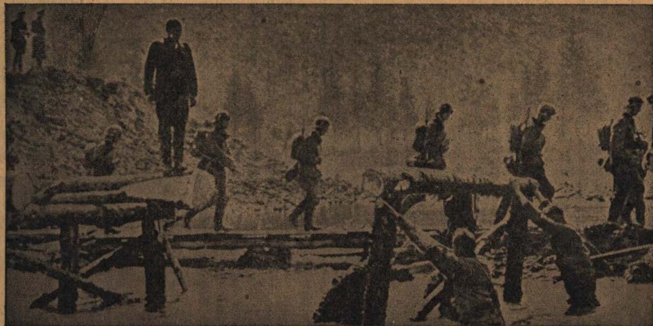
Pontoneiros alemães construindo uma ponte fixa em substituição a outra destruída pelos franceses em sua retirada
