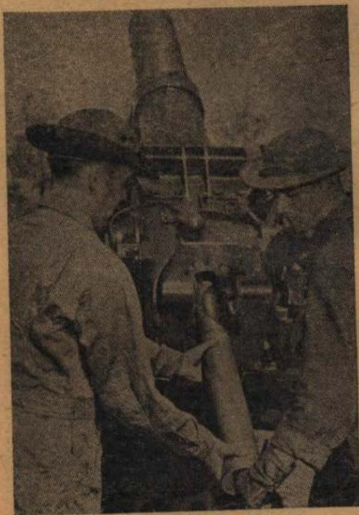
**DEDOS MECÂNICOS** no cortador de espoletas armam a espoleta do projétil para explodir precisamente na altitude determinada. Este engenho, montado próximo à culatra do canhão, é também comandado pelo cérebro mecânico. À direita, municionadores introduzem um projétil na culatra numa tarefa de conjunto típica em todo exercício anti-aéreo.
