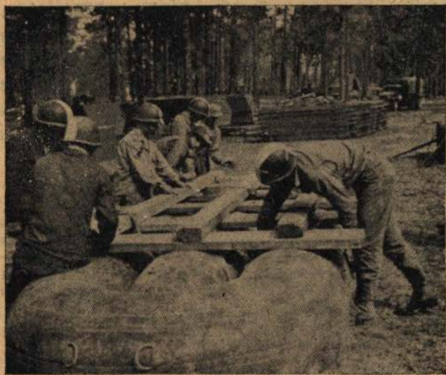
Fixação das vigas ao bote.
