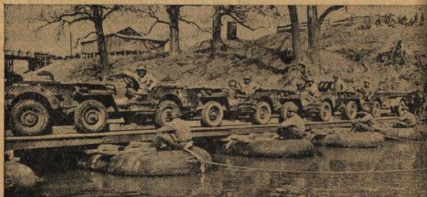
Ponte empovizada com o material descrito neste artigo, e carregada com "jeeps".
