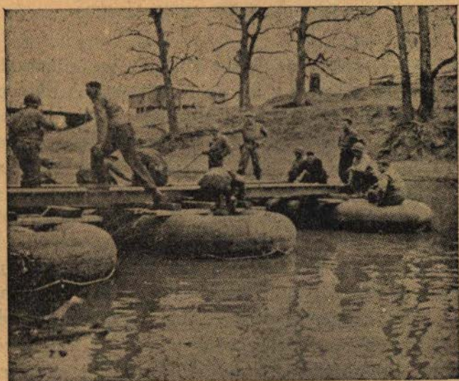
Ligação dos painéis em puros metálicos
