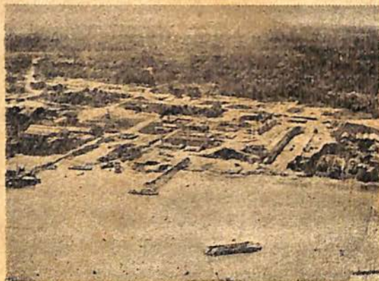
Vista aérea da zona industrial da Base. Nesta época ainda não havia iniciado a construção da Oficina Geral.
