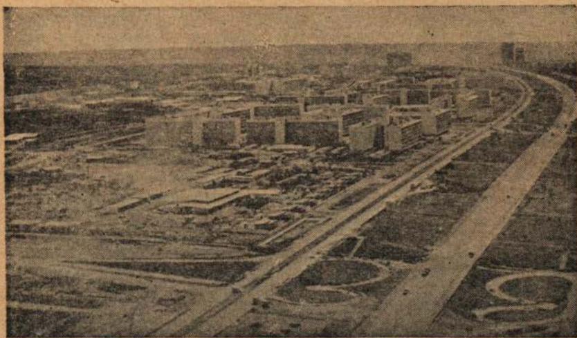
FOTO AÉREA DA CURVA DO EIXO RODOVIÁRIO
