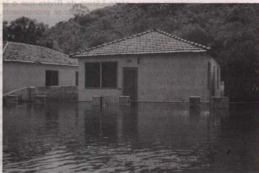
A Vila dos Sargentos totalmente invadida pelas águas do rio Paraguai. A fotografia data de maio de 1982.
