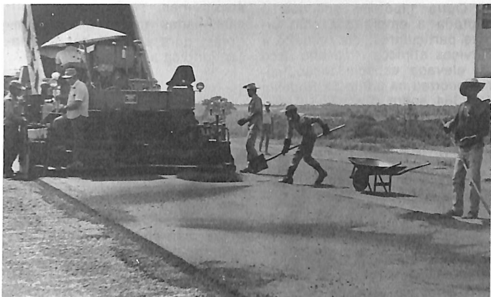
Figura 7. Civis e militares, juntos, ajustam uma camada de concreto betuminoso usinado a quente, em alguma rodovia.
