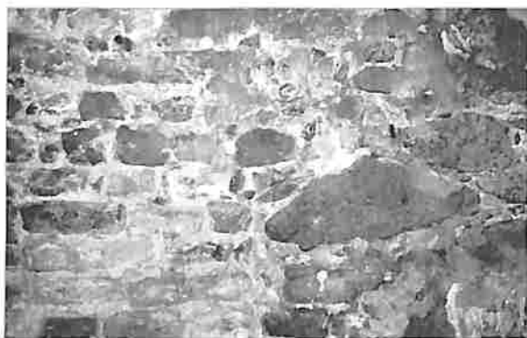
Parede interna da Casa de Deodoro
