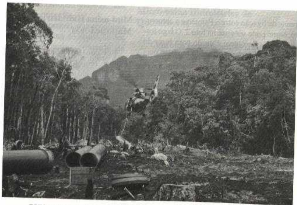
FOTO 3: Transporte dos equipamentos para o local da mini-usina de Maturucá
