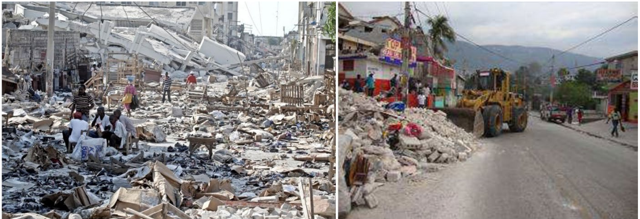
Figura 4 – Trabalhos de desobstrução das vias da capital.
