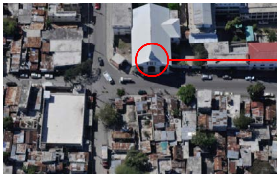
Fotografia Aérea e aproximação com luneta de Elm F Adv [9]
