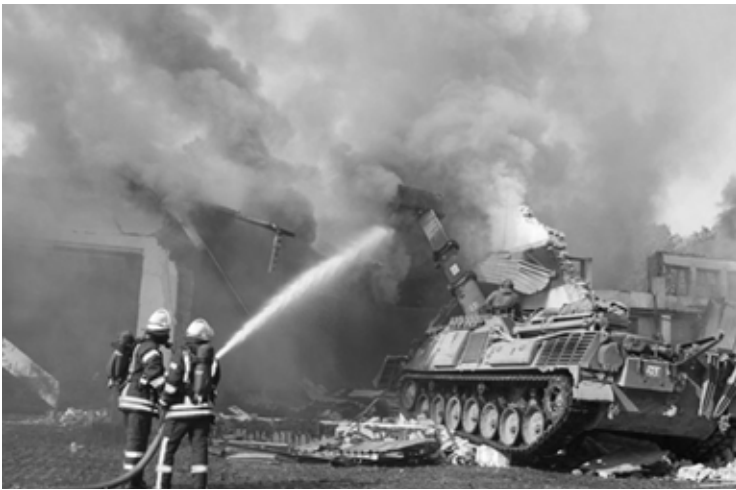
Figura 5: VBE Eng apoiando trabalho de demolição. Fonte: DeutschesHeer, 2018
