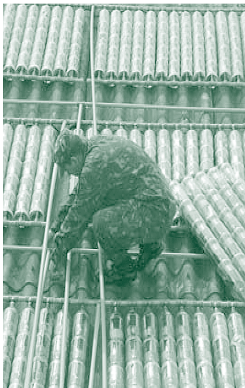
Figura 1 – Aquecedor solar ecológico Fonte: Sd Joacir Marcos Corrêa, da 15ª Cia Eng Cmb
