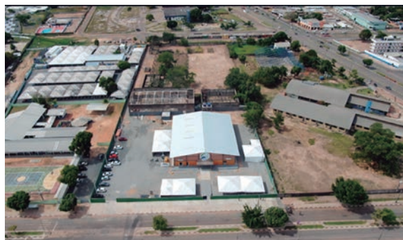
Figura 3 – Instalações do Centro de Coordenação e Interiorização e do Centro de Capacitação e Educação em Boa Vista Fonte: Banco de dados da Operação Acolhida
