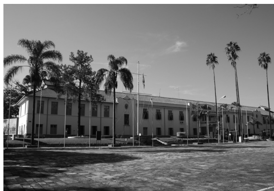
Figura 3 – Fachada do Pavilhão de Comando e pátio de formatura da ESA
