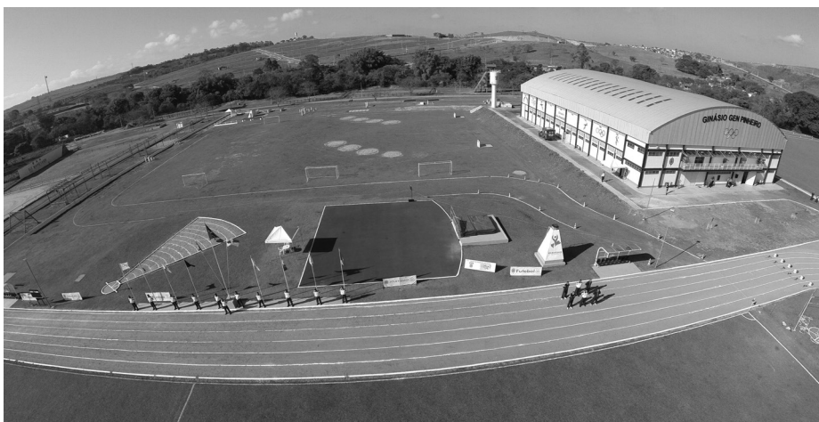
Figura 5 – Vista aérea do novo complexo esportivo da ESA
