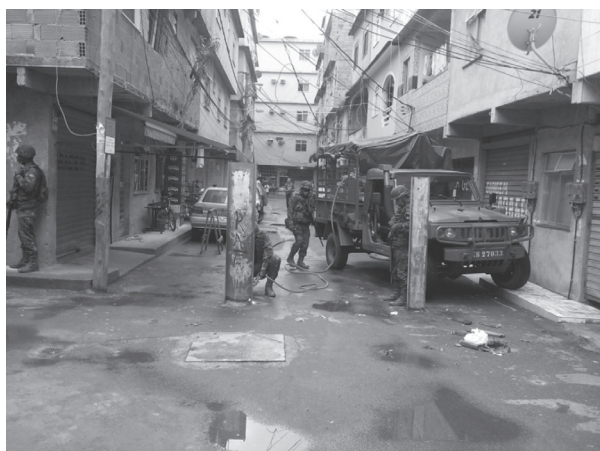
Figura 7 – Liberação de via, início dos trabalhos
