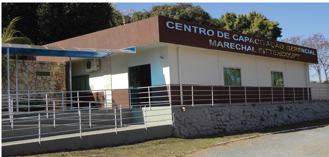
Foto 02 - Centro de Capacitação Gerencial Marechal Bittencourt (CEGAGE)
