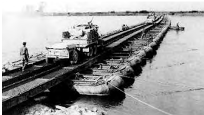
Figura 01: Ponte construída pelo Batalhão de Engenharia Fonte: www.chicomiranda.wordpress.com
