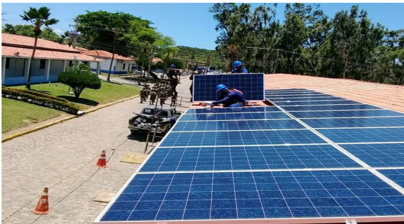
Figura 3: Instalação de placas solares no 7º BE Cmb.
