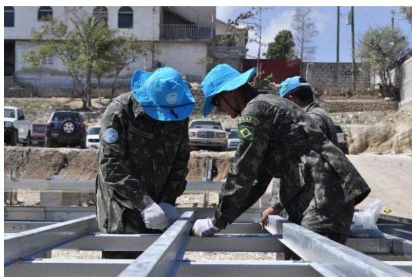
Figura. 7: Montagem de pré-fabricados Fonte: Comunicação Social BRAENGCOY 21
