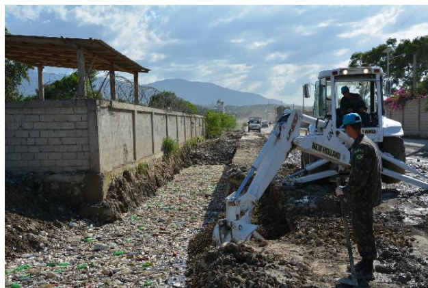
Figura. 5: Desobstrução de vias e canais Fonte: Comunicação Social BRAENGCOY 21
