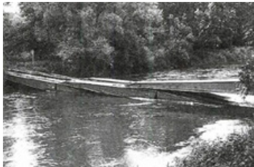
Figura 7: Ponte conjugada sobre um fosso anticarro. Fonte: TDV 2350/030-12: Panzerschnelbrücke Biber
