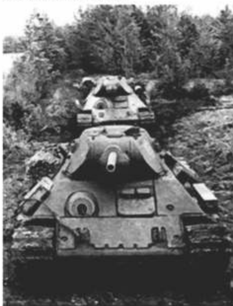
T 34 progredindo em terreno de lama - Nota-se a largura das lagartas
