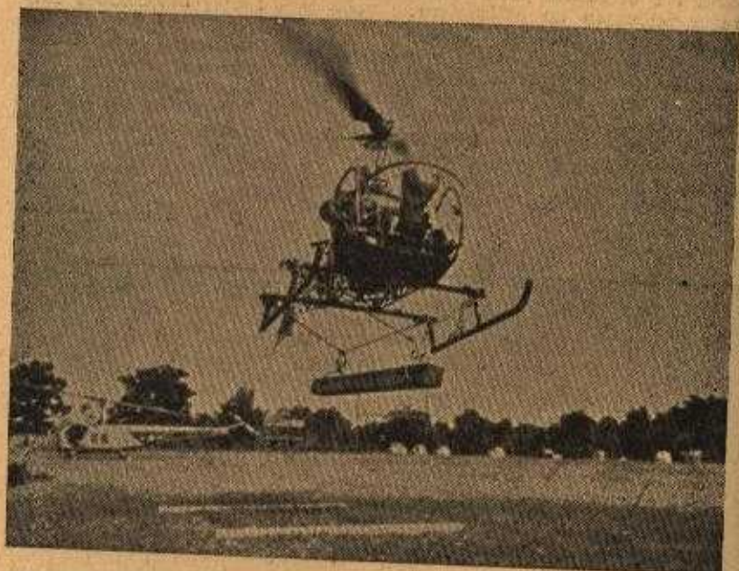
Fig. 3 — Experiência de carregamento, transporte e colocação de vigotas
