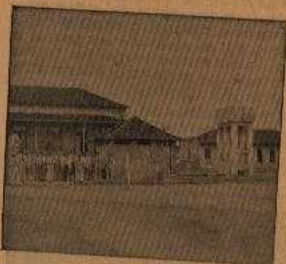
Fig. 11 — Quartel da Cia. de Fronteira em Pôrto Velho.
