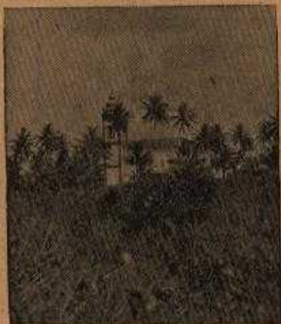
Fig. 20 — Igreja dos Prazeres, nos Guararapes (Recife).
