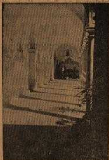
Fig. 25 — Interior da Igreja de S. Francisco (Bahia).
