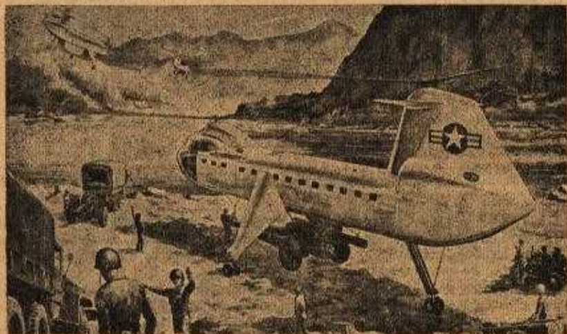
Helicóptero XH-16, do Exército americano, sendo usado para transportar um obus de 155 mm
