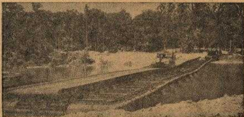
Fig. 3 — A ponte sobre suportes flutuantes, de aço, de modelo simplificado, pode suportar o tráfego pesado das divisões de infantaria e blindadas
