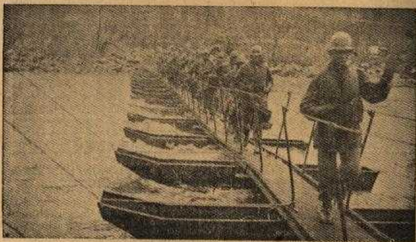
Fig. 2 — A passadeira sobre suportes flutuantes, muito leve e rapidamente construída, facilita a travessia dos cursos d'água pela infantaria
