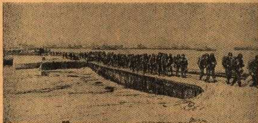
Fig. 5 — Tropas descendo de um barco LCT sobre o leito enxuto de uma ponte de desembarque construída com pontões afundados. (Pag. 391 da mesma revista)
