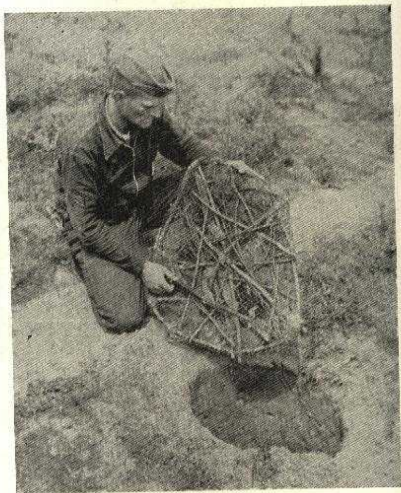
Fig. 6 — O sargento Thielmann D. Muse demonstra, aqui, como é construído um "buraco de aranha". Depois de feita a excavação, cobre-se o fosso com uma espécie de tampa com as mesmas características do terreno em que estiver colocada.
