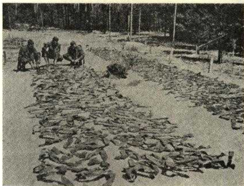
Fig. 4 — Materiais artificiais para um teto falso são estendido junto do "Fort Belvoir". Esses tetos-falsos são colocados sobre os ninhos de metralhadoras e canhões para ocultá-los do ataque de aviões inimigos e da fotografia aérea.
