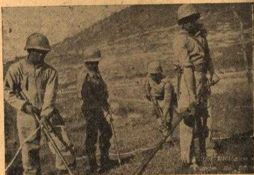
O detetor com o soldado Odir, os provadores com os soldados Belmiro, Rêgor e Caetano e as fitas brancas. O detetor precede os provadores por se tratar aqui de uma pose fotográfica...
