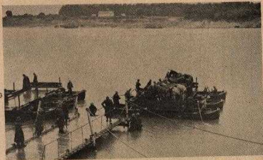
Largando da ponte fixa preparada pelo 2.º Batalhão de Pontoneiros.
