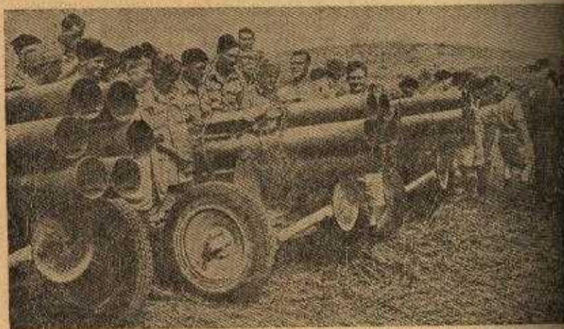
Figura 5 — A foto acima nos mostra tropas inglesas examinando os lança-foguetes alemães capturados no norte da África. Aparecem aí os chamados Nebelwerfer 41 , com calibre de 150 mm, compostos de 6 tubos e pesando 540 quilos descarregados. Possuíam um campo de tiro horizontal de 24° e vertical de — 6° a 45°, atirando projétils de 35 quilos, com alcances da ordem de 6.700 metros
