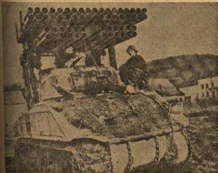
Figura 2 — Dispositivo lança-foguetes montado em um tanque Sherman. Pode-se fazer uma idéia da potência de fogo representada por esse material, considerando que aí se acham montados 60 tubos lança-foguetes. Esse lança-foguete é denominado nos Manuais americanos como "4.5 inch Rocket Launcher T 34".
