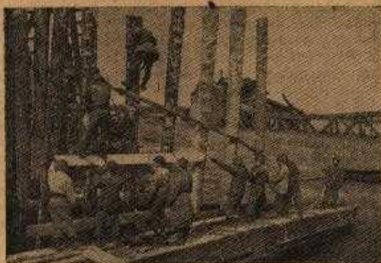
Contraventamento provisório das estacas
