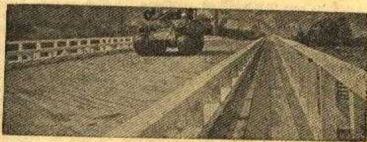
Fig. 5B — Um carro de combate sobre a ponte concluída
