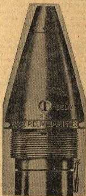
Fig. n. 7 — Espoleta equipada com o detonador-reforçador M20 A1
