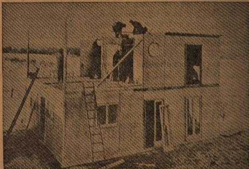
Montagem de uma casa de 5 peças, 2 andares, em elementos prefabricadas
