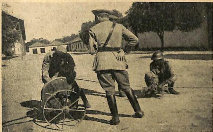
Enrolamento do cabo, depois de reparafinado. Utiliza-se um carrinho desmontador
