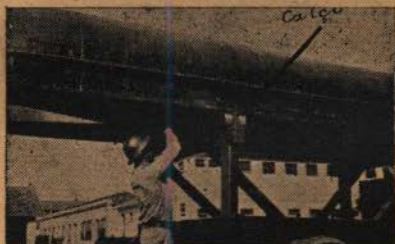
Como se carrega uma vigota. Vê-se o "calço" para facilitar a operação, o qual se retira depois.
