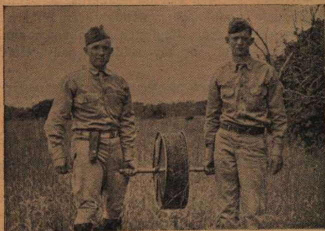
Fio telefônico sendo transportado pela equipe do observador. A bobina DR-4 transporta uma milha de fio e todo o conjunto que vemos pesa cerca de 80 libras.
