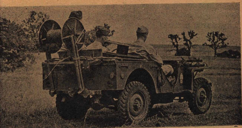
Carro "bantan" de \frac{1}{4} de tonelada, com bobina modelo DR-5 adaptada. Essa bobina tem capacidade para 2 milhas de fio W-130.
