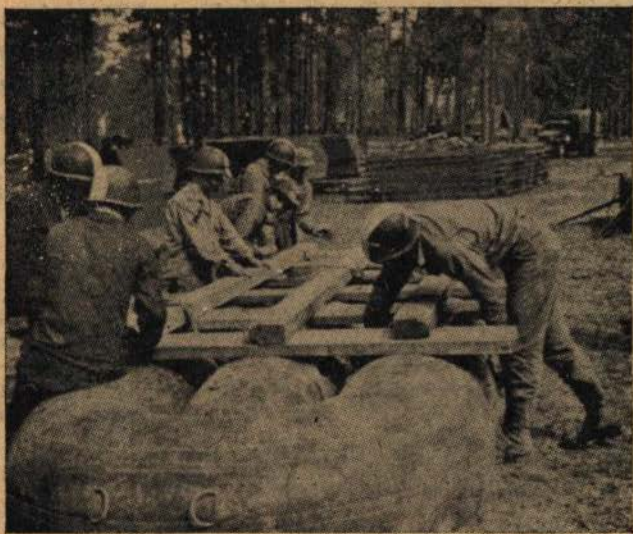
Fixação das vigas ao bote
