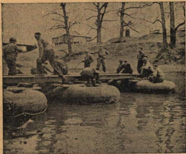
Ligação dos painéis em puros metálicos
