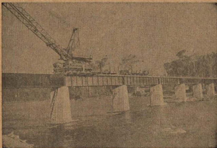
Outra vista da ponte sôbre o Amapari, vendo-se o guindaste de lançamento das vigas
