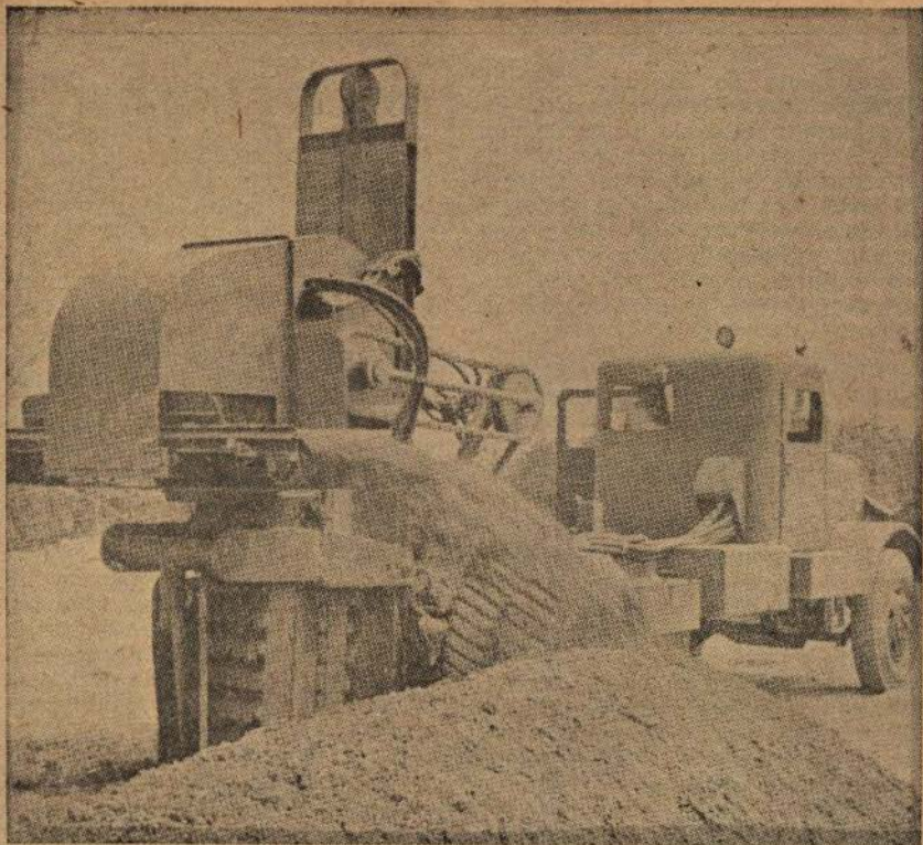
Fig. 1 — Capacidade de construção significa a movimentação de grandes quantidades de lama, rocha e neve. Aqui vemos uma nova máquina de cavar trincheiras, que pode construir um abrigo individual em dez segundos
