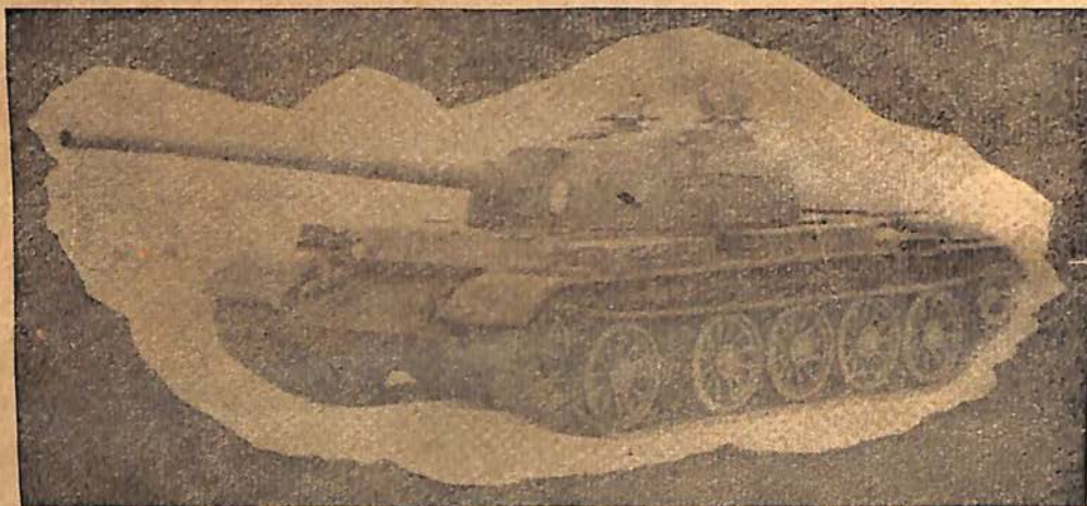
Fig. 1 — Tanque T-54, produzido em massa, tem armadura mais grossa do que o T-34, canhão mais potente e pode viajar mais de 320 km sem reabastecimento, silhueta mais baixa.
