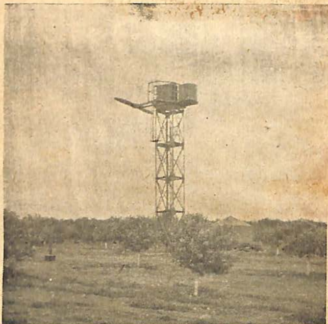
Fig. 3 — Um dos enormes ventiladores, movidos a motor de avião, utilizados na movimentação das camadas de ar, evitando os efeitos danosos da geada. Utilizados juntamente com os aquecedores, sendo que se pode apreciar um deles, bem destacado, na parte inferior esquerda da fotografia.
