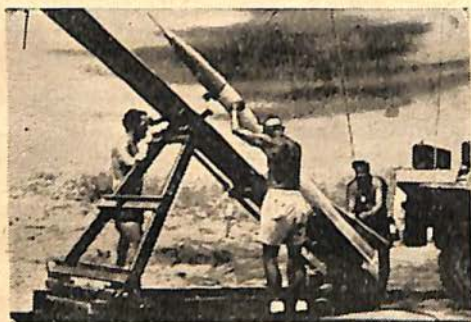
Na última prova da bomba H, usaram-se foguetes como este, para efetuar registros da precipitação radiativa
