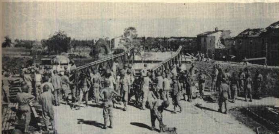
Uma das 12 pontes Bayley construídas pela Engenharia da FEB, na campanha da Itália. Aparece na foto construída em setembro de 1944, a E de Pisa com 45 metros. (Arquivo do autor).
