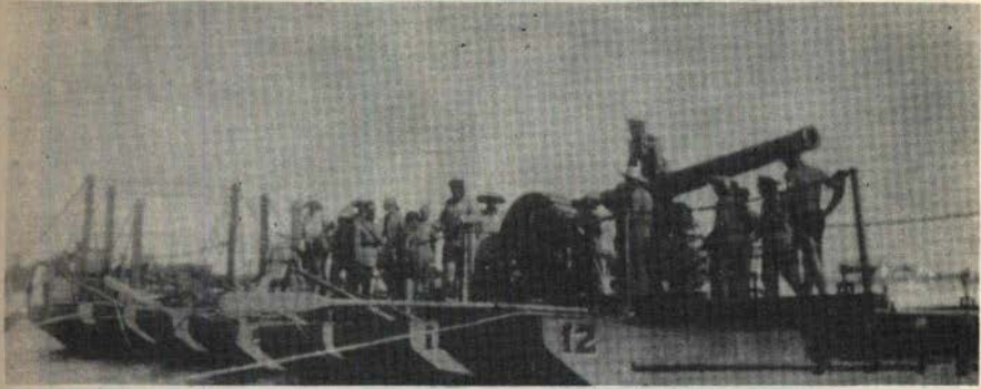
Estes foram os primeiros serviços prestados pelos pontões, do que seria a B4-A1. Eles na parte superior eram vedados com madeira para impedir que fossem tomados pela água do mar. (Foto Mal. José Machado Lopes).
