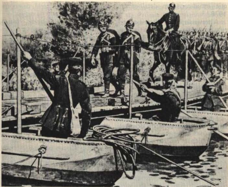
Equipagem Birago — prussiana do tipo que o Brasil adquiriu duas em 1851, para a guerra 1851-52 e que se constituiu na primeira ponte de equipagem que o Exército possuiu. (Foto arquivo do autor).
