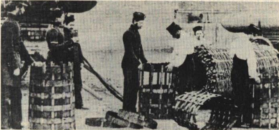
Pontões de goma elástica do tipo usado pelo Corpo de Engenheiros na Guerra da Tríplice Aliança contra o Paraguai. Aparecem carregados em carroças (Ver História dos Exércitos e Tavares, A História da Arma de Engenharia).
