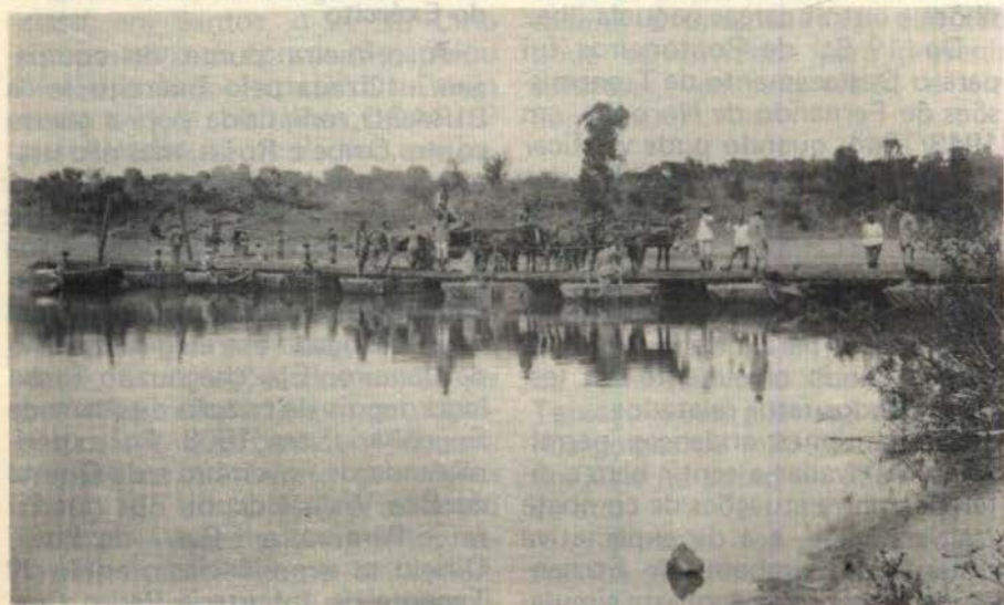
Ponte americana, tipo DC em 1922, lançada pelo 3.º BEComb, então em São Gabriel. Os botes constituíam-se de uma armação envolta em lona. (Foto do arquivo do então Ten Eng Paulo Bolívar Teixeira).
