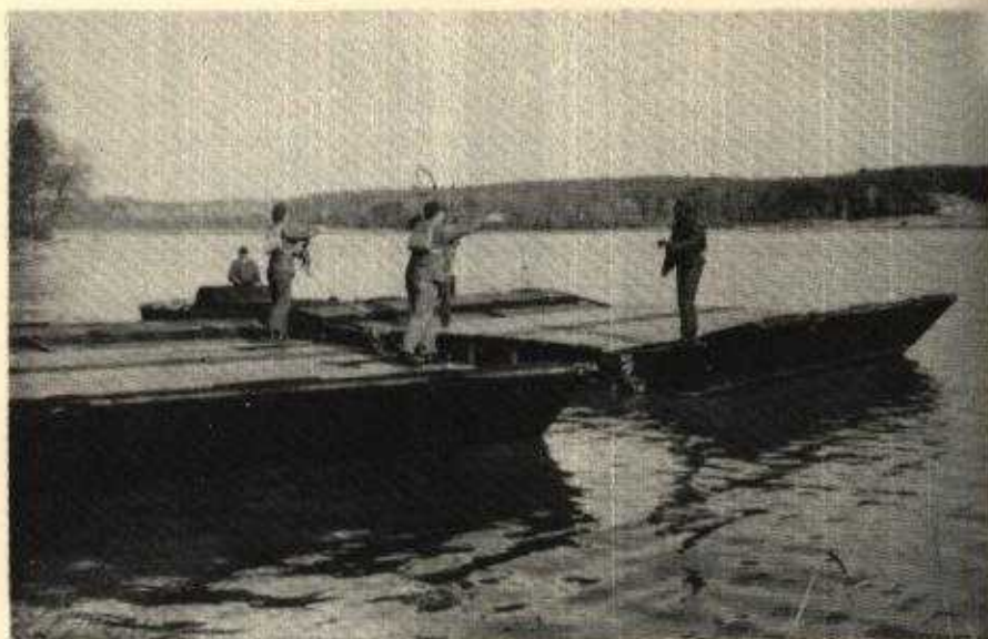
As seções da ponte são interligadas
