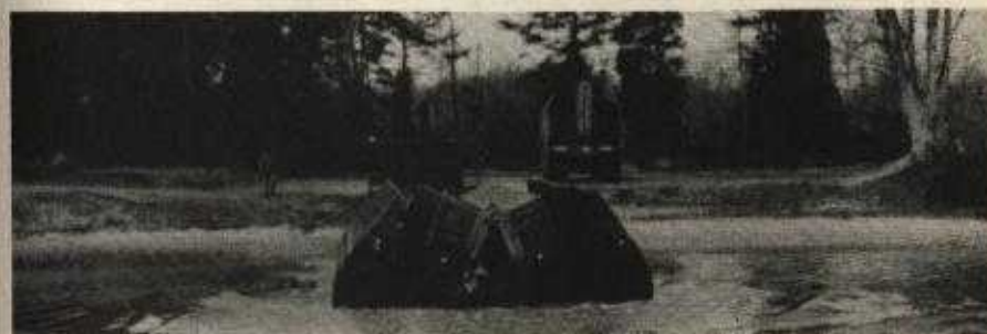
A ponte é lançada no rio por efeito da gravidade
